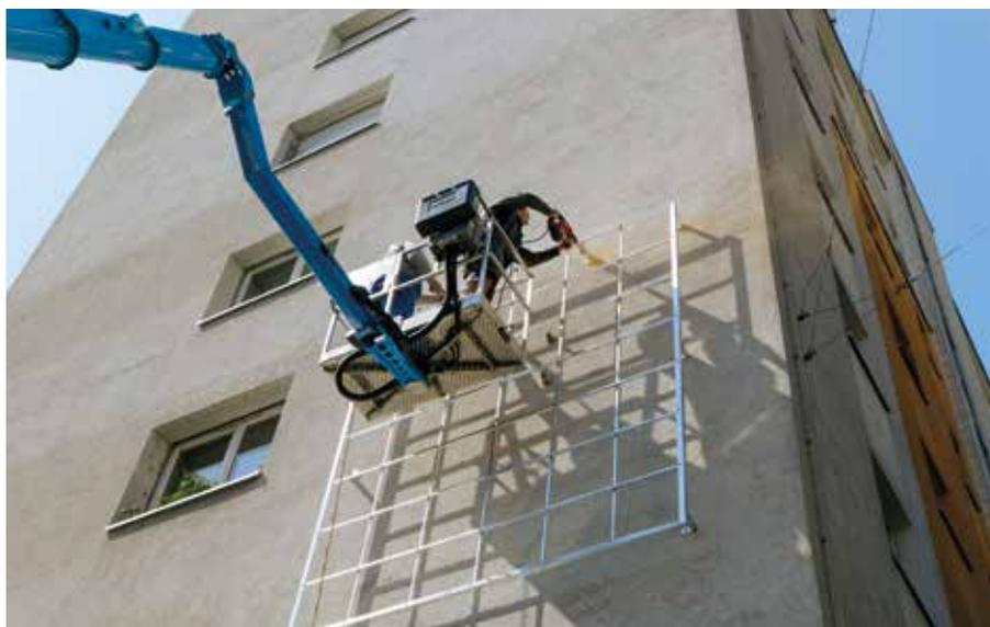
Die Kletterhilfen für die Pflanzen bestehen aus Aluminium und Stahl. Die Module haben eine Maschenweite von 50 x 50 cm und lassen sich beliebig erweitern.
