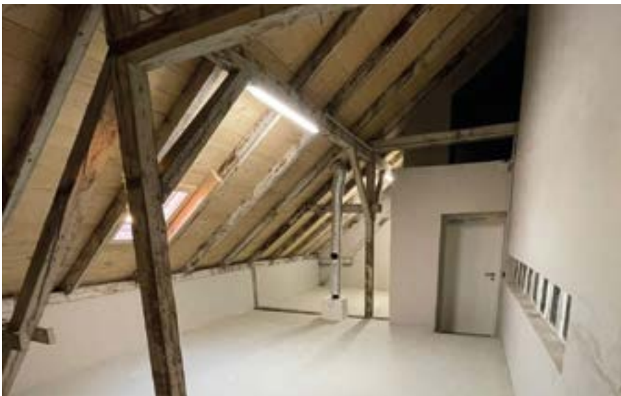
Wärmedämmung der obersten Geschoßdecke und der Wände zum Dachboden
